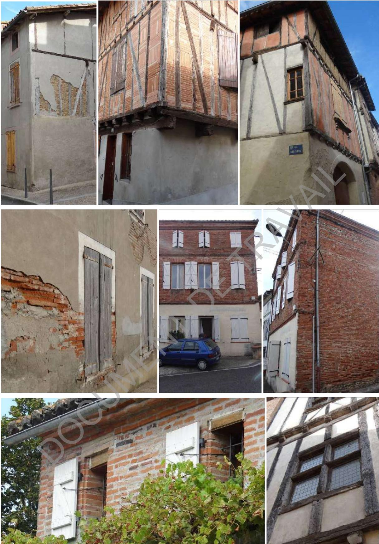
La surface des murs extérieurs présente plus ou moins d'ouvertures avec, selon la date de construction et les travaux qui ont été réalisés depuis, entre 10% et 40% de surface vitrée. On retrouve encore beaucoup de menuiseries anciennes en bois et du simple-vitrage.
