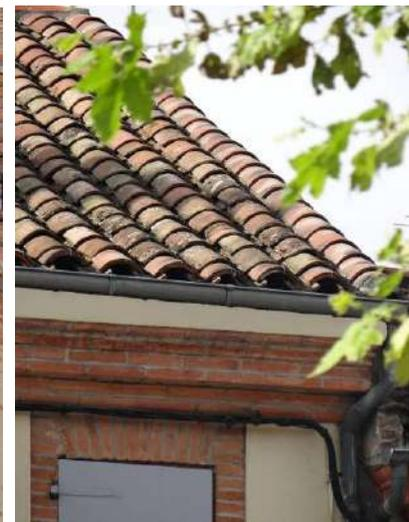
A noter que ces constructions anciennes présentent souvent des infiltrations d'air importantes à travers l'enveloppe. En effet, les parois anciennes étaient conçues pour « respirer » ; le bâti était très perméable à l'air et, sans ventilation mécanique, il doit absolument le rester pour éviter les problèmes d'humidité.
