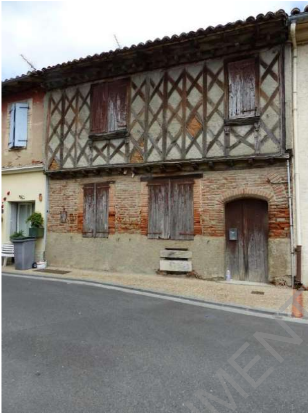
La maison médiévale dite de La Falguière
