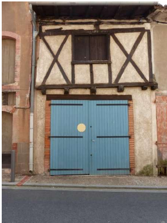
Façade en pan de bois 16 e siècle
