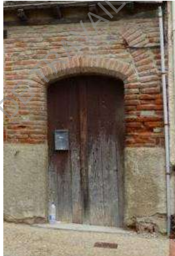
Les édifices majeurs
