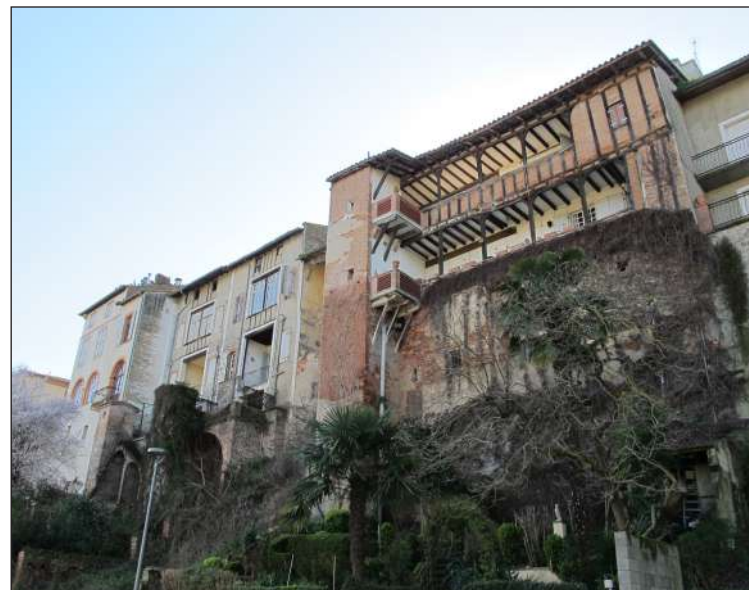
Verdun, le front urbain et ses encorbellements
