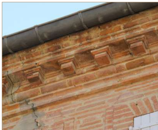
corniches à modillons
