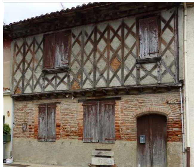
Façade en pan de bois à résille. Maison dite de la Falguière, 16e siècle
