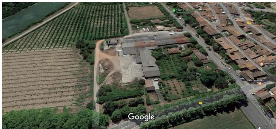
vue générale sur l'usine parmi les peupleraies (doc. google)
