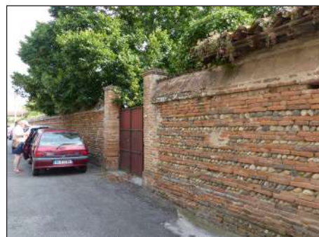
mur de clôture en assises alternées de galets et de briques
