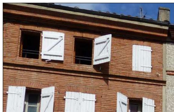
baies d'attique néoclassiques
