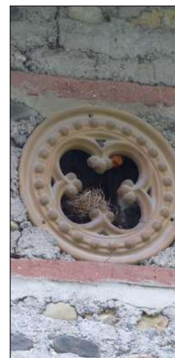
aération de comble néogothique
