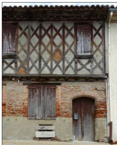
Façade en pan de bois d'intérêt majeur
