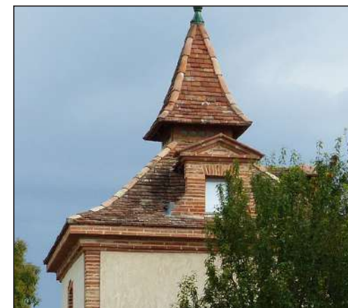
toiture en pavillon avec lanteron et épi de faîtage
