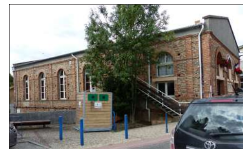
salle des fêtes - parements de galets et de briques
