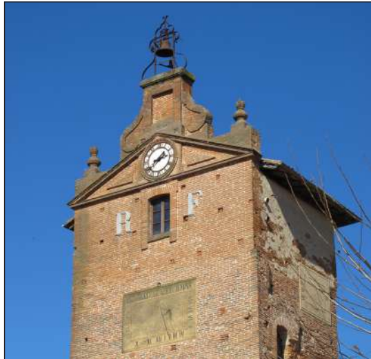
tour de l'Horloge : fronton classique (17e siècle ?), campanile de fer forgé et cadran solaire
