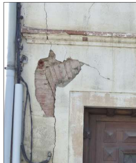
vestiges d'une baie cintrée remplacée par une baie rectangulaire
