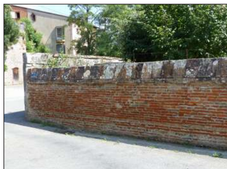
mur de clôture en briques pleines apparentes
