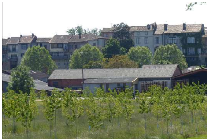
les toits de l'usine depuis EBI le pont sur la Garonne
