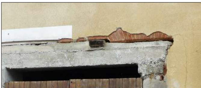
linteau clavé et chanfreiné remplacé dans un premier temps par une baie à chambranle simulé puis par un linteau de béton
