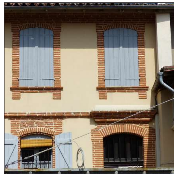
parement de briques - composition mise en valeur par un crépi de chaux
