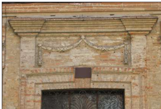
baies à entablement mouluré
