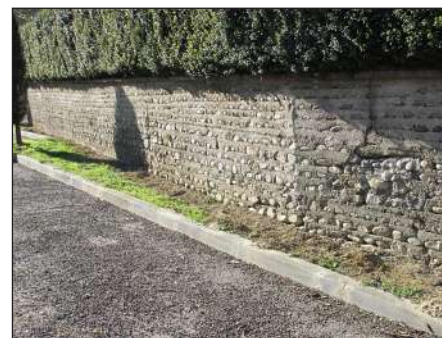
mur de clôture en assises galets
