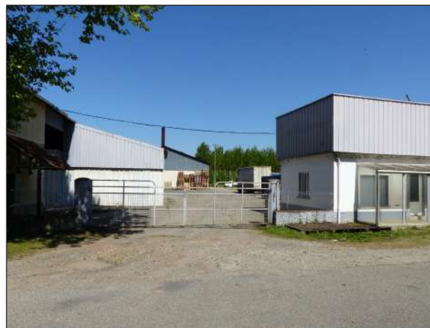
entrée de l'usine sur l'allée des Remparts
