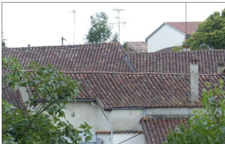
couvertures de tuiles canal
