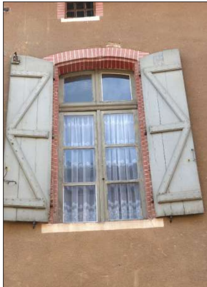
châssis à traverse dormante - contrevents à écharpes
