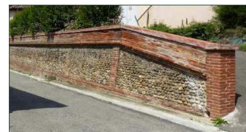
mur de soutènement : briques, assises de galets et chaperon plat
