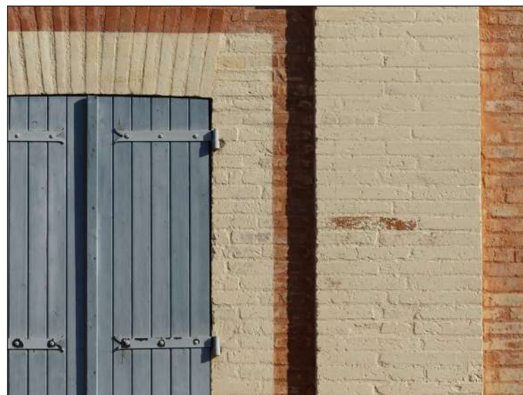
parement de briques cuites rehaussé par badigeon
