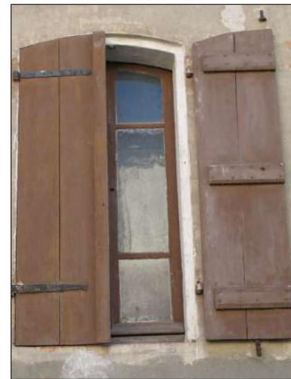
châssis à carreaux inégaux (art déco) contrevents à traverses
