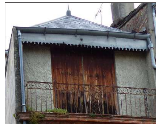
couvertures d'ardoises et lambrequin de tôle découpée
